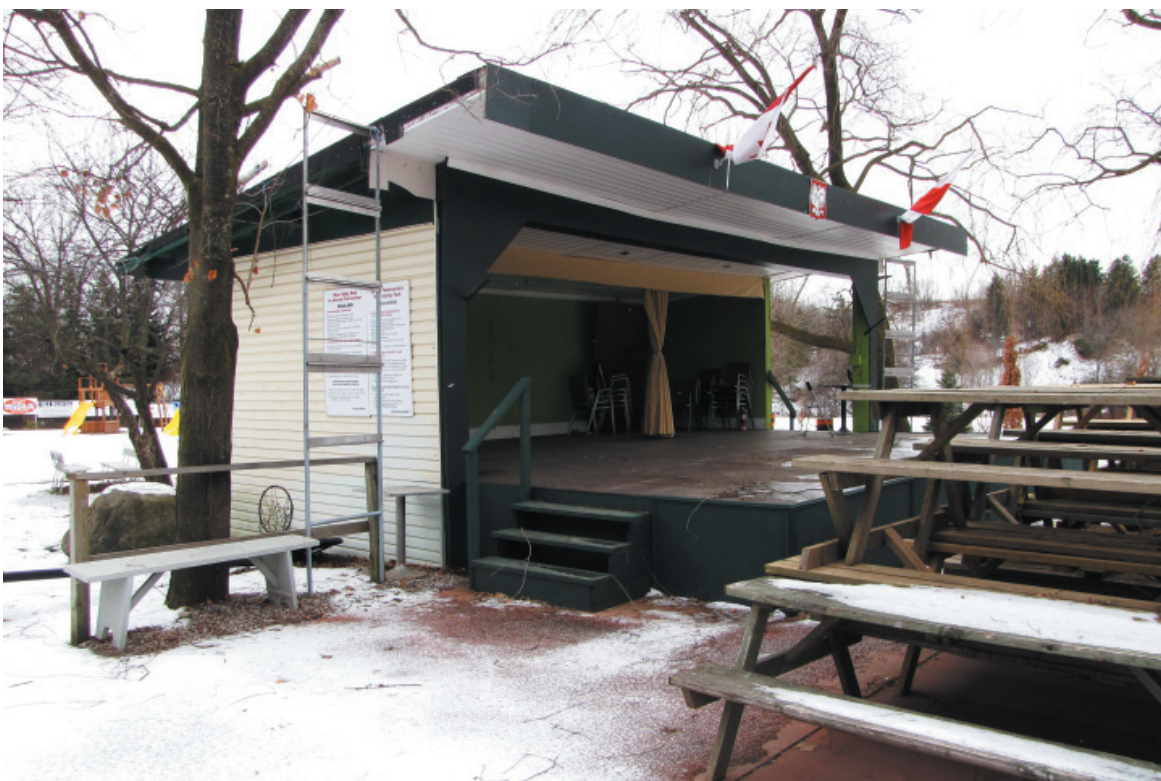
Istniejącą starą scenę trzeba będzie przebudować
